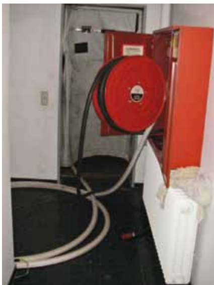
Bild 2 Unkoordinierte Schlauchreserve.
