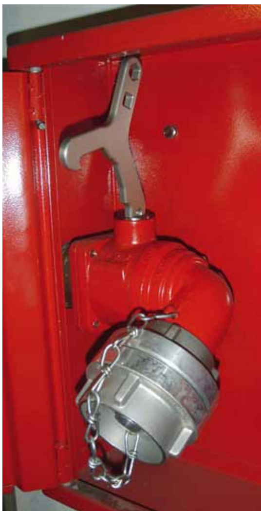
Bild 1 Wandhydrant: Öffnung der Tür und Bedienung des Ventils mit einem Werkzeug.
