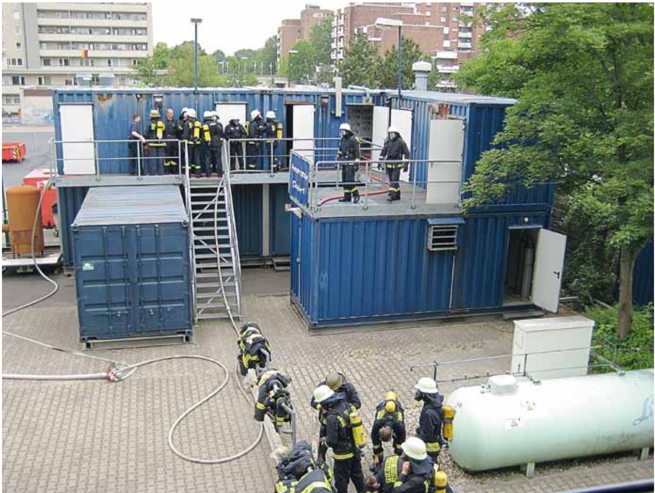
Bild 1 Komplexe Containeranlage der Feuerwehrschule Düsseldorf (gas- befeuert).
