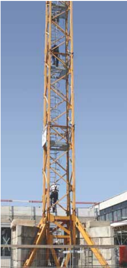
Bild 2 Nachstieg von Einsatzkräften des Rettungsdienstes auf Turmdrehkran an gespanntem Fixseil.
